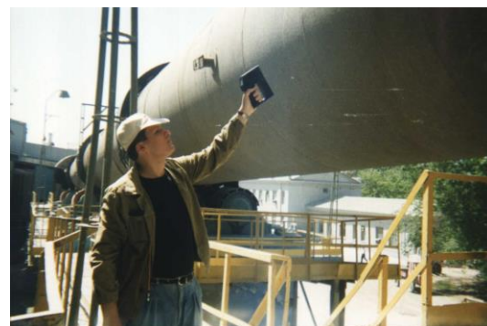
Обследование цементной вращающейся печи
