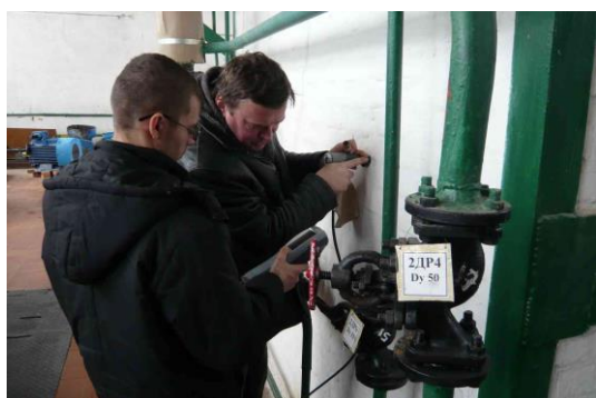
Обследование центральной котельной пгт. Ивня
