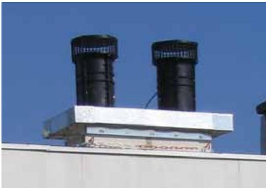
4 Вентиляторы низкого давления, установленные на оголовках вентканалов.
