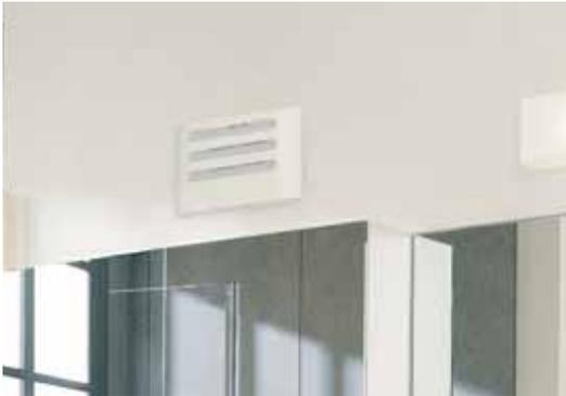
2 Гигрорегулируемое вытяжное устройство, установленное в ванной комнате.
