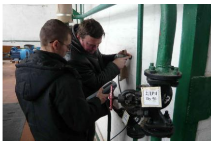
Обследование центральной котельной пгт. Ивня
